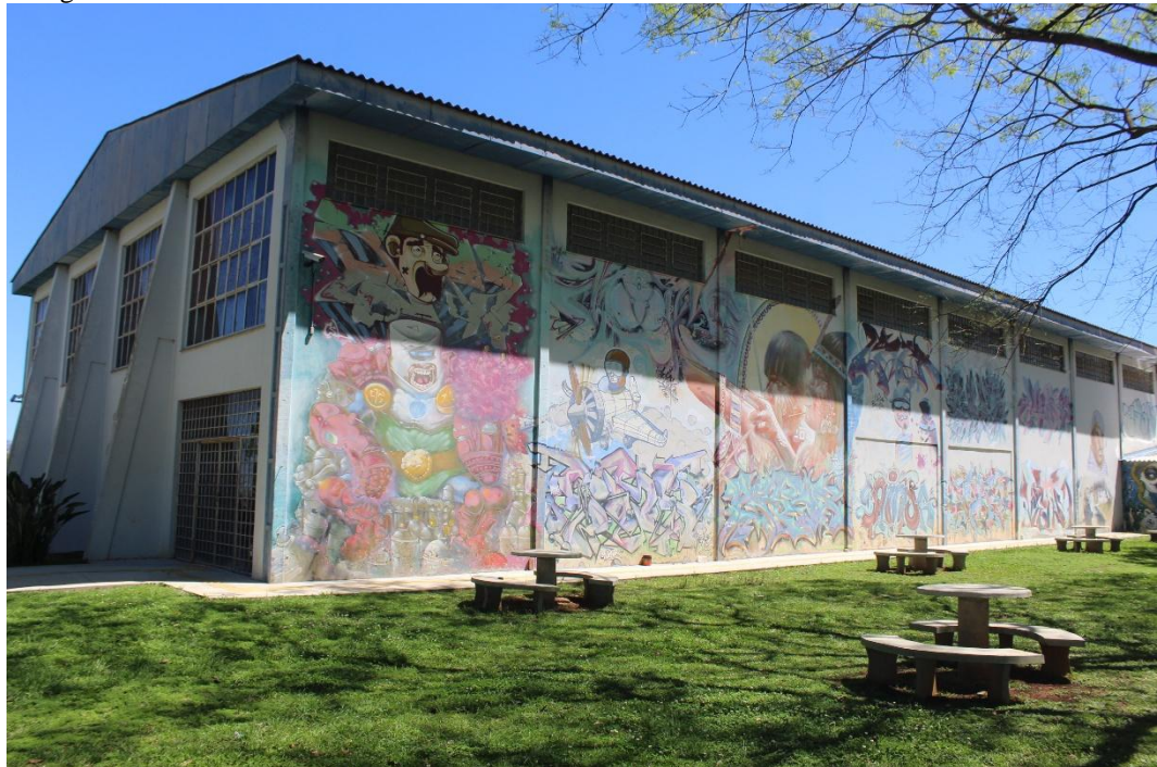
Fotografia 16 - Centro de Convivência
