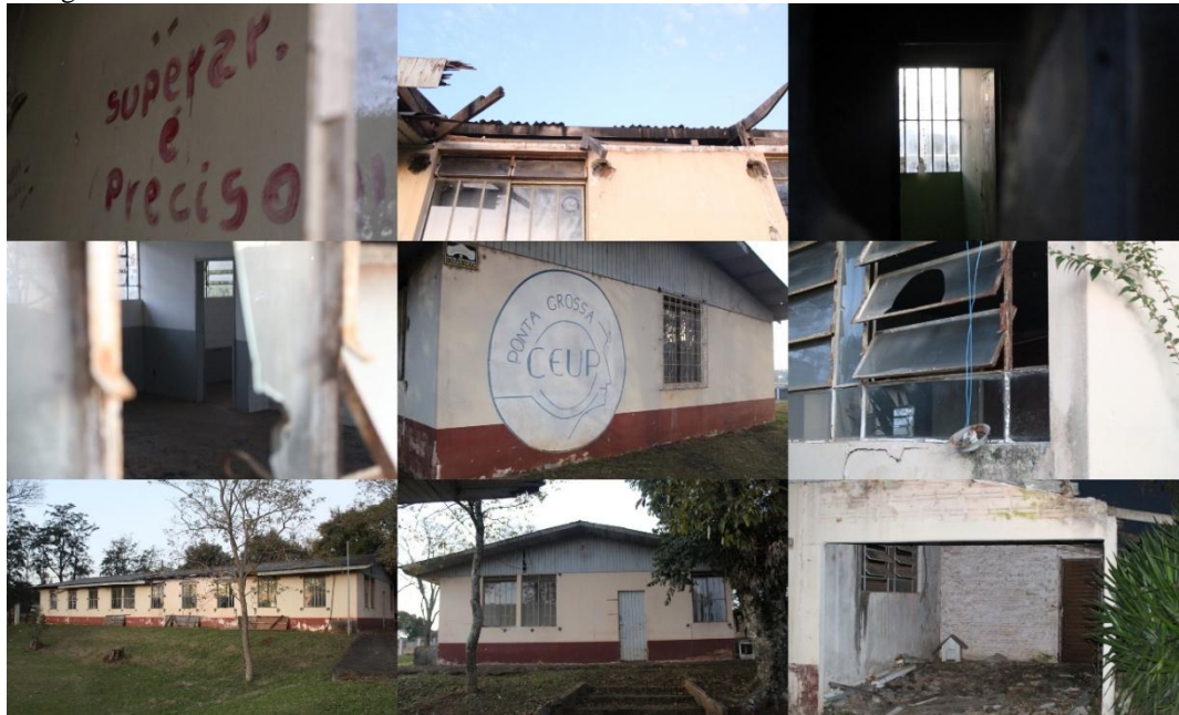
Fotografia 18 - Prédios da CEUP desativados
